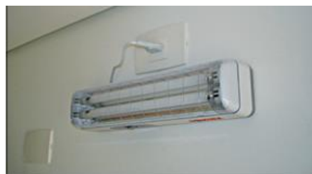
Bloco de iluminação de emergência
